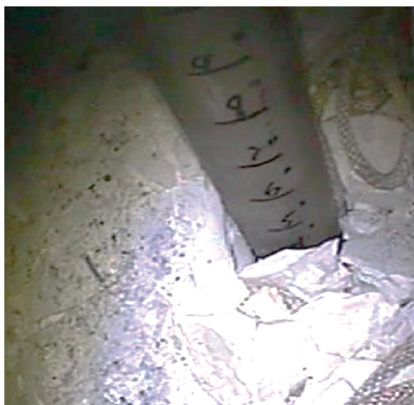
Рис. 4. Участок треснувшего 4-дюймового слоя бикарбоната натрия в баке первого контура реактора EBR-II
