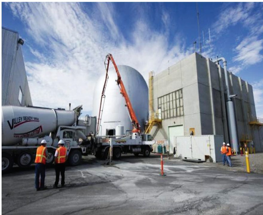
Рис. 3. Внешний вид площадки реактора EBR-II
